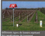
Différents types de bornes repérant les canalisations de transport
