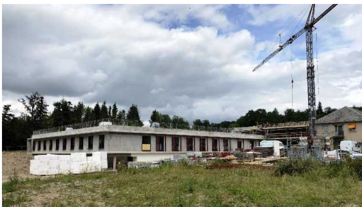
travaux USLD en juin 2018
