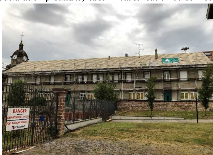
toiture arrière du bâtiment mairie école en août 2019
