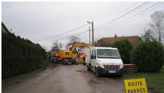
travaux d'assainissement rue de la tuilerie
