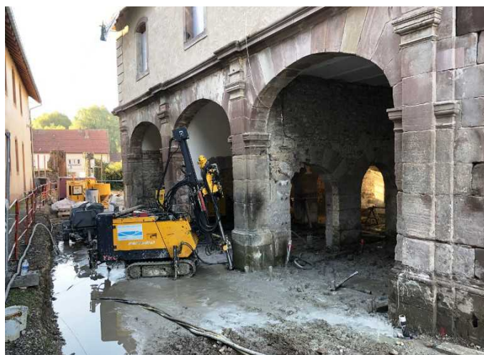
consolidation des fondations sur le bâtiment faïencerie
