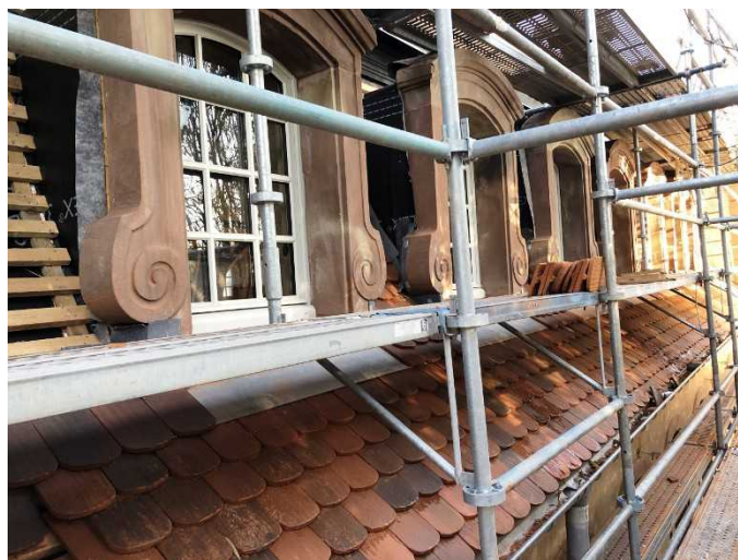
les travaux de toiture, et les nouvelles fenêtres
